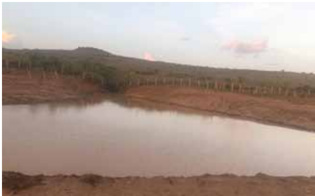
Kwa Mboo earth dam
